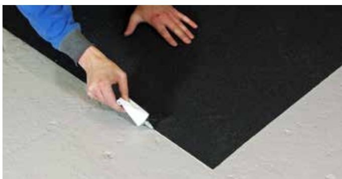
Szegélyragasztó alkalmazása a szalag szélén
